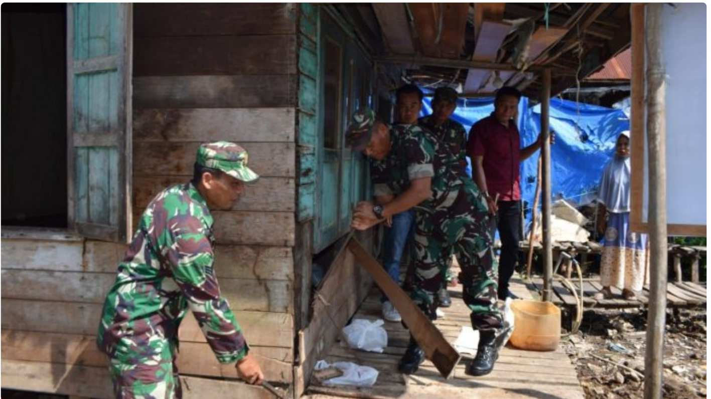
Dandim 1005/Barito Kuala Tinjau Langsung Pelaksanaan Bedah Rumah Tidak Layak Huni (RTLH)
